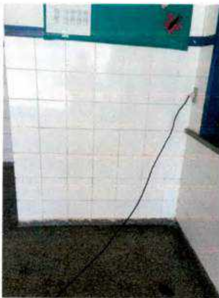
Antes da instalação (foto 01)
