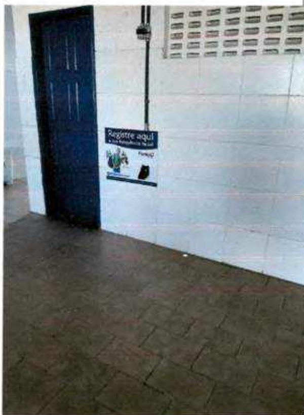
Instalado ao lado da sala de aula
