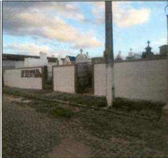
Fachada frontal do muro do cemitério
