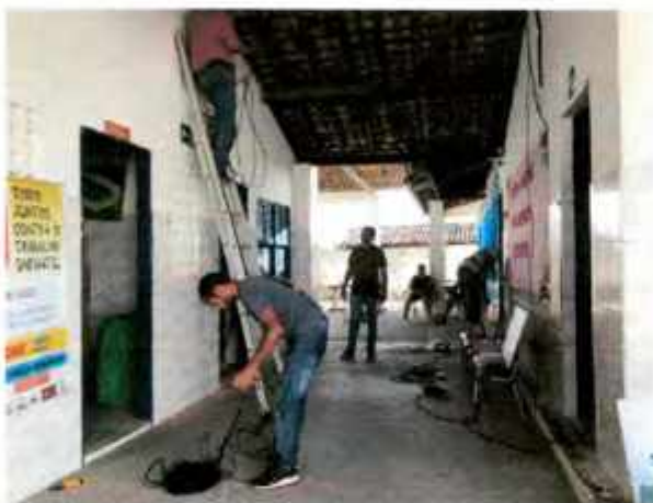
Durante a instalação
