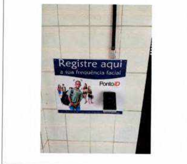
Controlador facial 01 Depois da instalação (foto 01)
