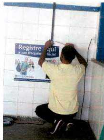
Durante a instalação (Foto 02)
