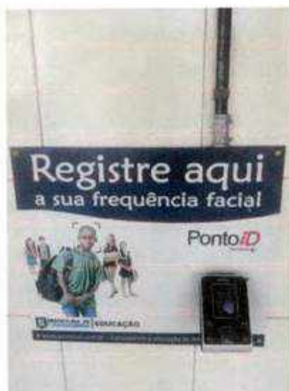
Depois da instalação
