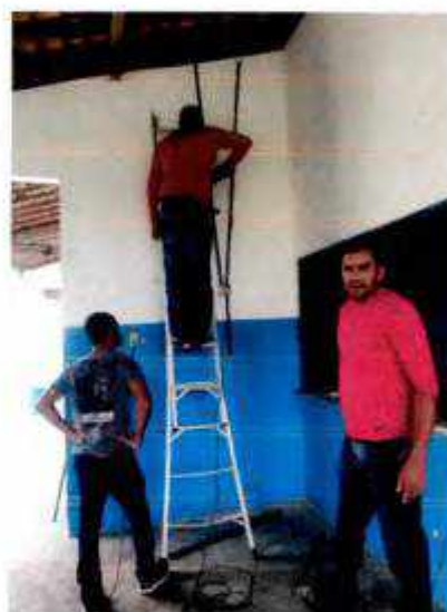
Durante a instalação (Foto 02)
