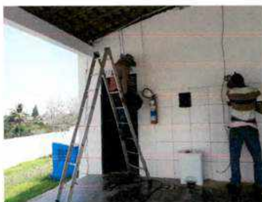
Durante a instalação
