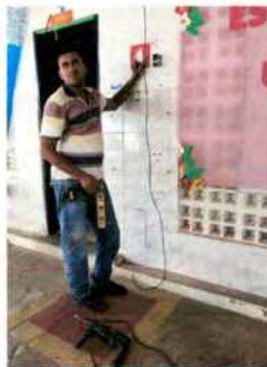
Depois da instalação
