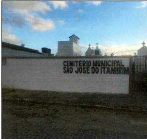
Fachada frontal do muro do cemitério
