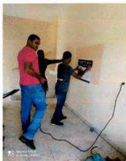
Durante a instalação
