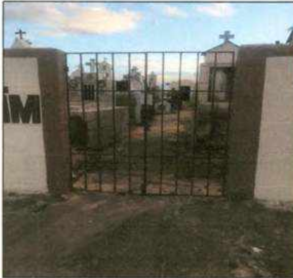
Portão de entrada
