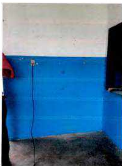
Antes da instalação (foto 01)
