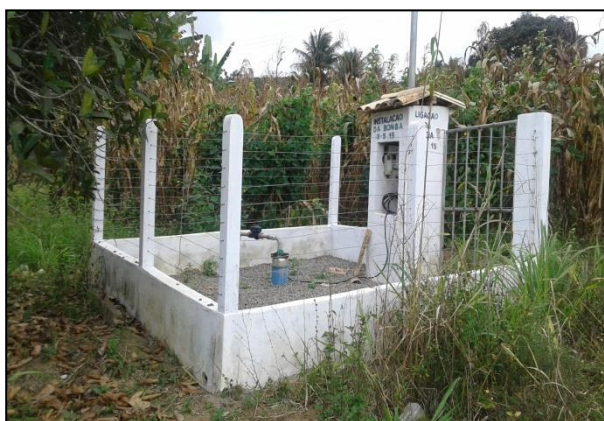
Figura 61: Poço no Pov. Cantinho da Bica
