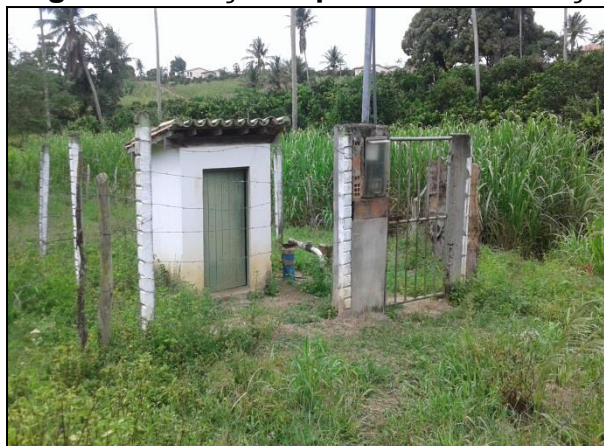
Figura 72: Poço no povoado Mumbaça
