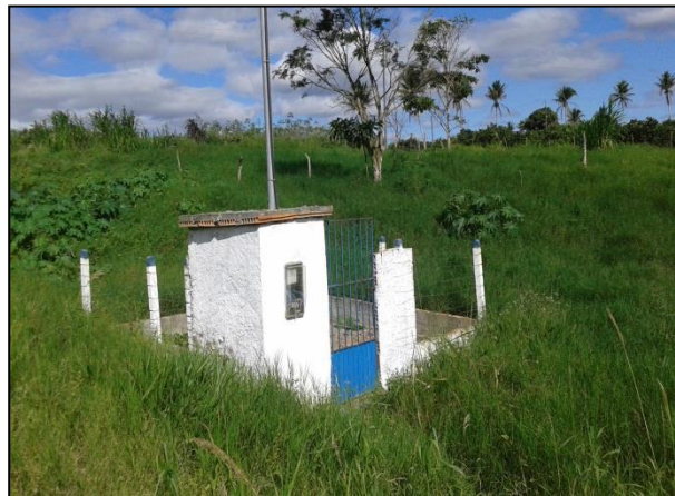
Figura 79: Poço no povoado Fonte Grande
