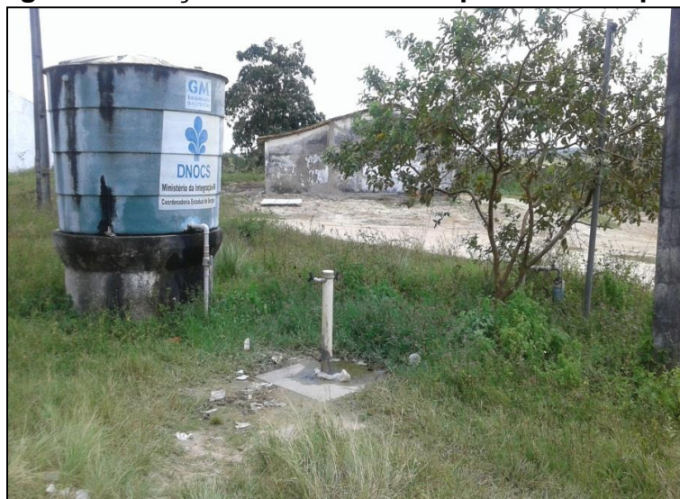
Figura 89: Poço e reservatório no povoado Muquém
