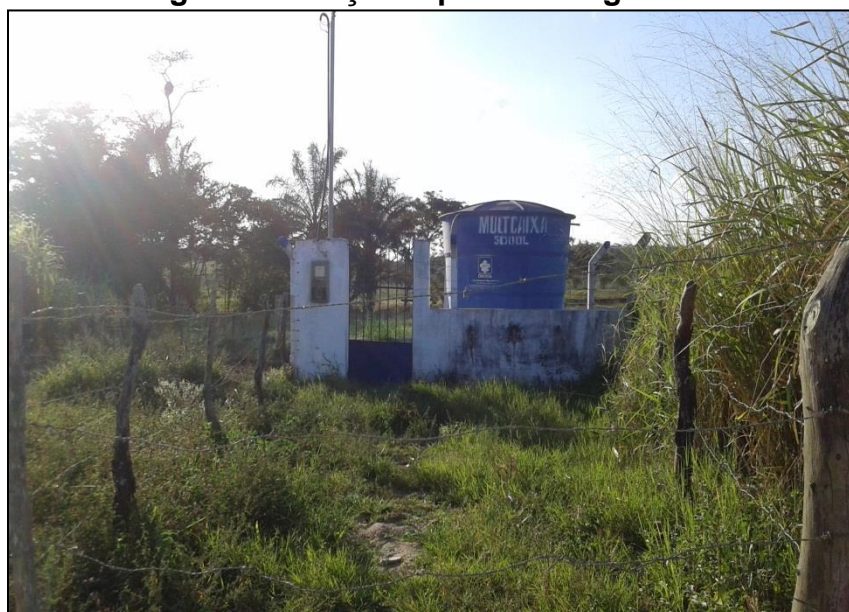
Figura 91: Poço no povoado Água Boa
