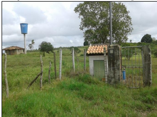
Figura 78: Poço e reservatório no sítio Salgado do Juazeiro
