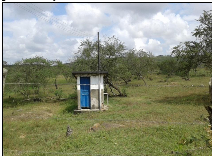
Figura 92: Poço tubular no Povoado Saco da Rainha
