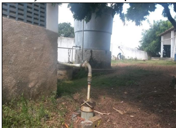
Figura 57: Poço e reservatório no povoado Vermelho
