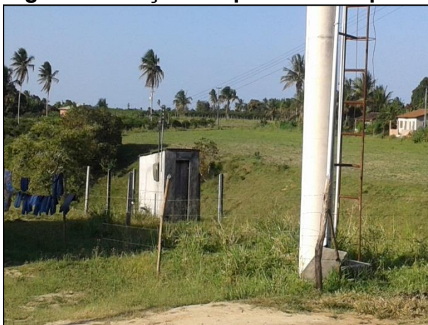
Figura 85: Poço 2 no povoado Dispensa
