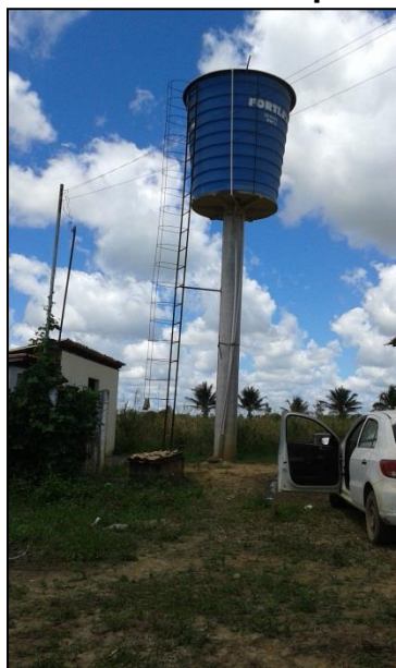
Figura 59: Poço e Reservatório no povoado Cipó Branco
