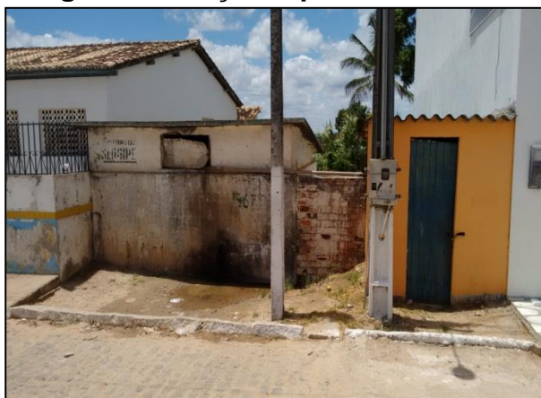
Figura 70: Poço no povoado Jardim
