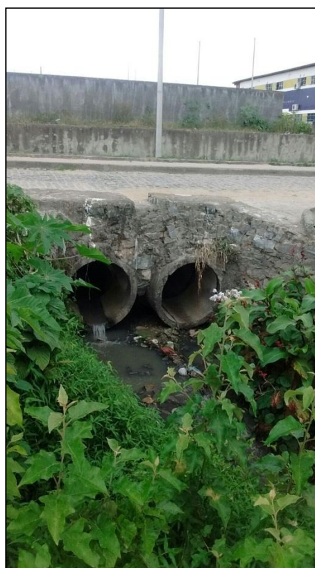
Figura 114: Saída da Rede de Drenagem
