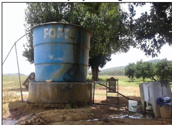
Figura 43: Ponto de captação da água da Fazenda Cajá
