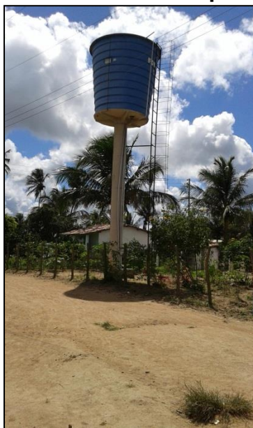
Figura 58: Poço e reservatório no pov. Borda da Mata
