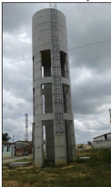
Figura 71: Reservatório em construção no povoado Jardim
