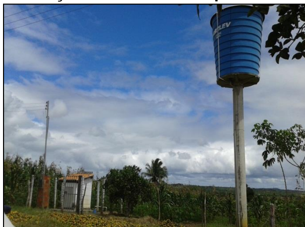
Figura 83: Poço e reservatório no povoado Mansinho
