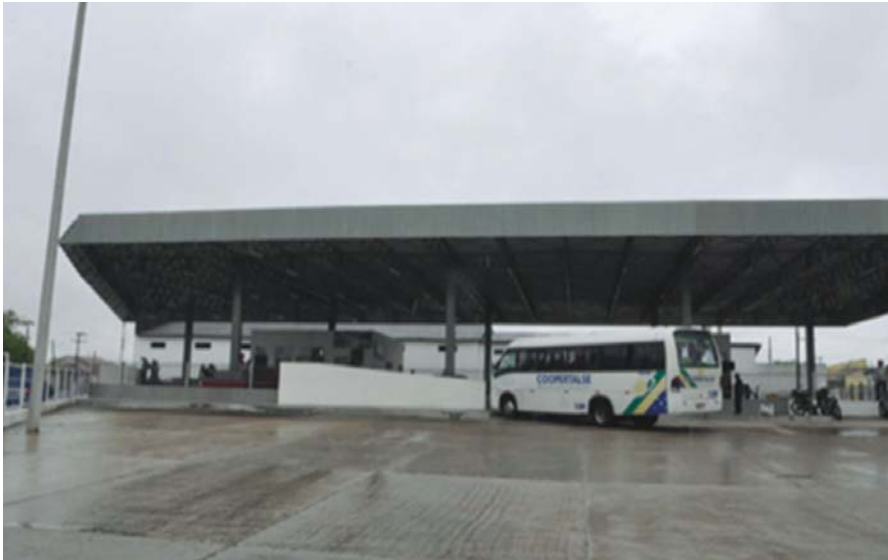
Figura 86: Terminal Rodoviário da cidade de Boquim.
