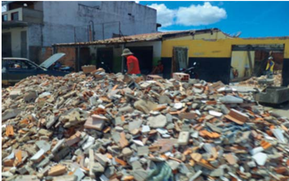
Figura 40: RCD: entulho de obra – Tobias Barreto/SE.
