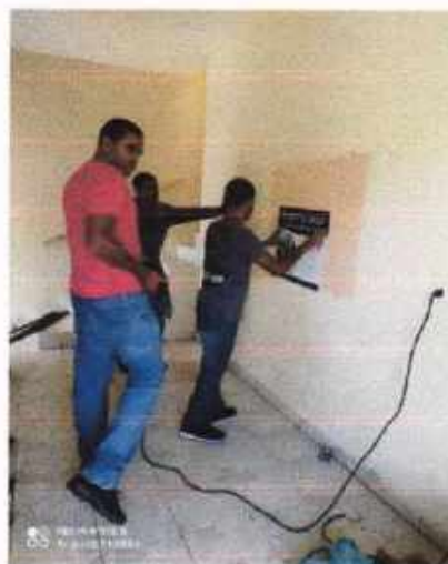
Durante a instalação
