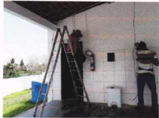
Durante a instalação
