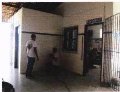
Durante a instalação
