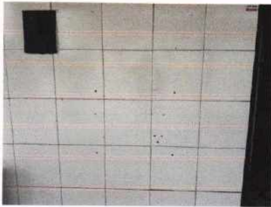
Antes da instalação
