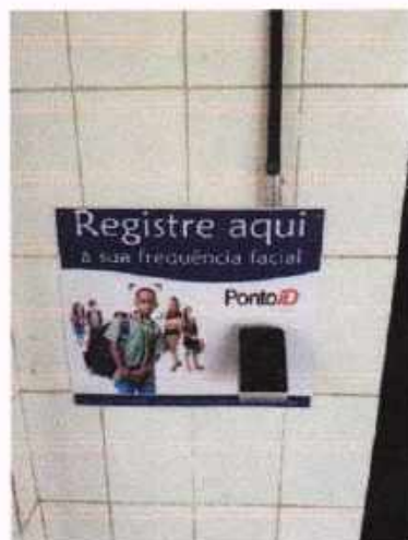
Controlador facial 01 Depois da instalação (foto 01)
