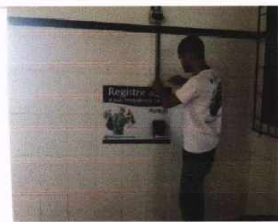
Depois da instalação
