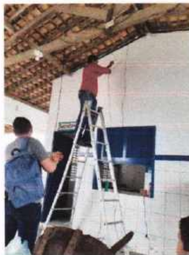
Durante a instalação (Foto 02)
