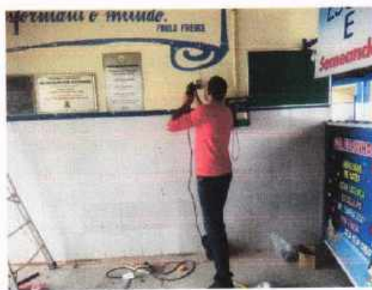
Durante a instalação (Foto 02)
