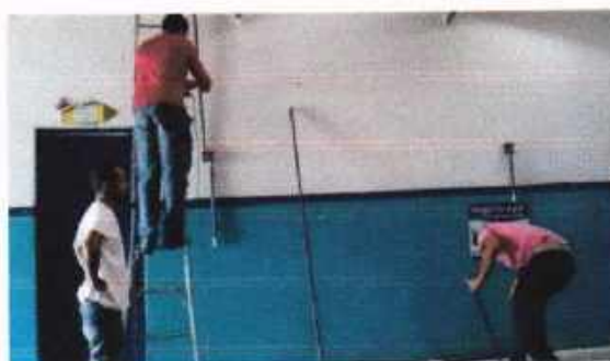
Durante a instalação
