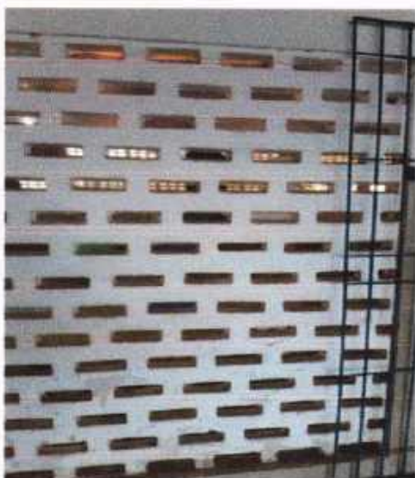
Antes da instalação
