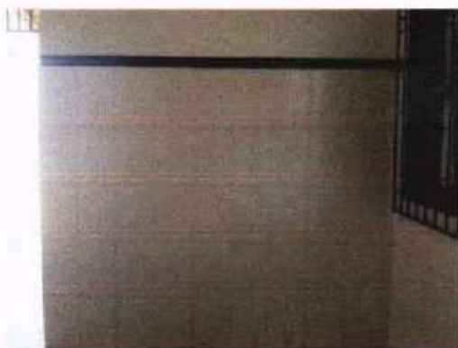
Antes da instalação
