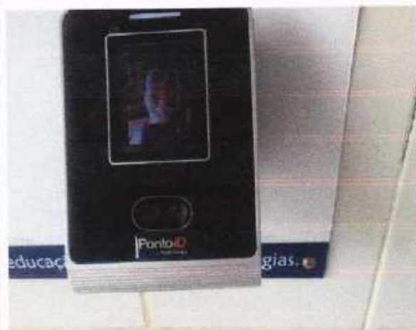
Controlador facial 02 (Depois da instalação)
