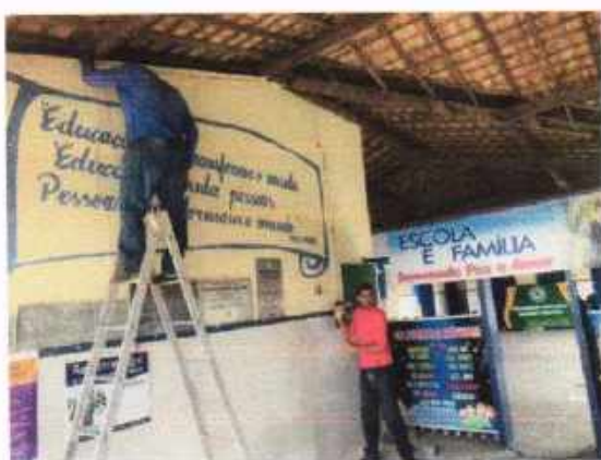
Durante da instalação (foto 01)
