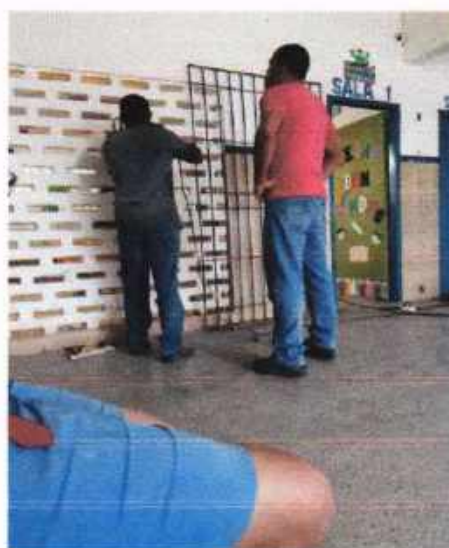
Durante a instalação
