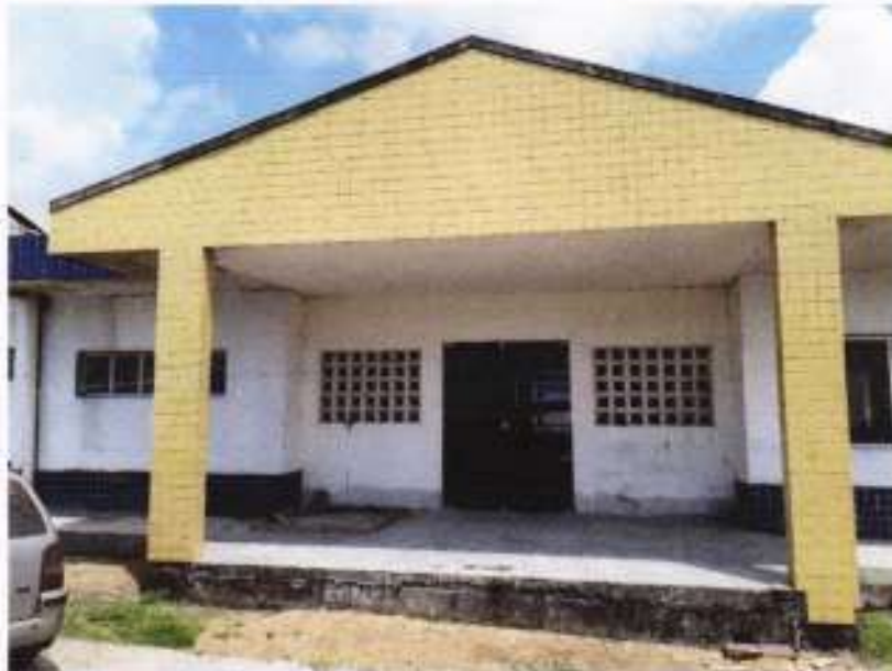
Foto 14: OBRAS REMANESCENTE DA CRECHE PROINFANCIA TIPO B
