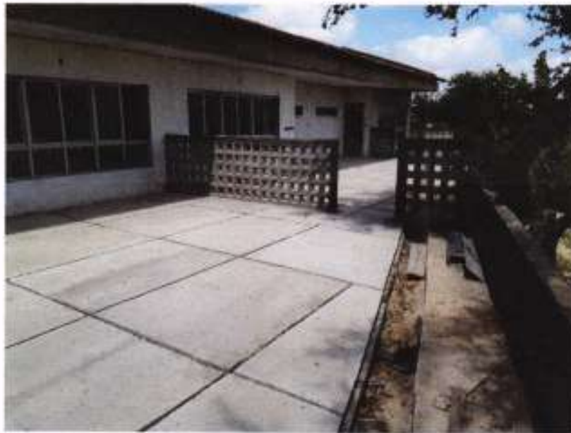
Foto 12: OBRAS REMANESCENTE DA CRECHE PROINFANCIA TIPO B
