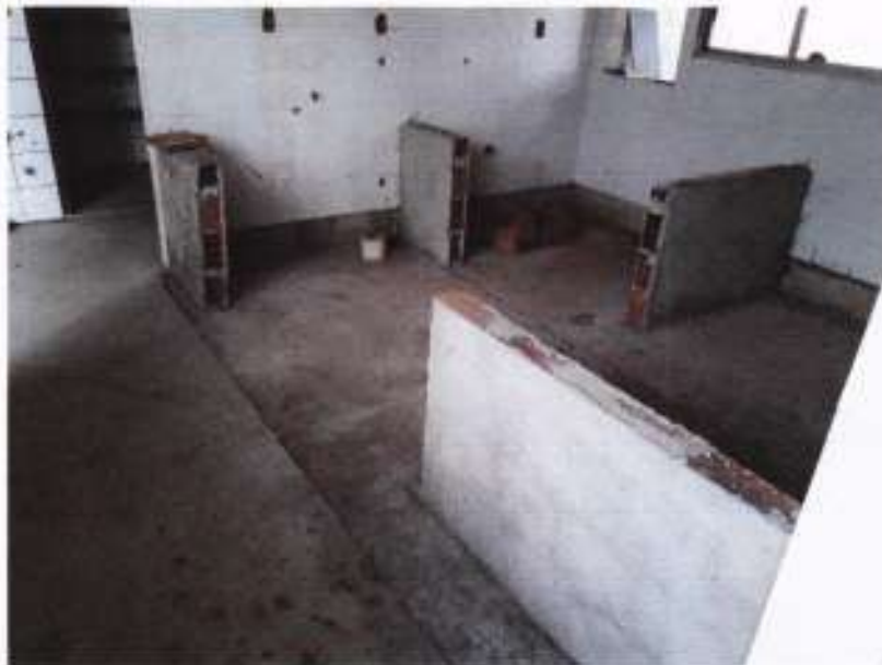
Foto 15: OBRAS REMANESCENTE DA CRECHE PROINFANCIA TIPO B
