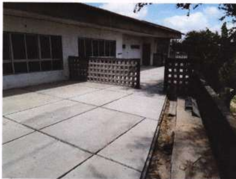
Foto 13: OBRAS REMANESCENTE DA CRECHE PROINFANCIA TIPO B
