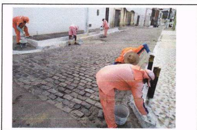
Pintura de meio fio;
